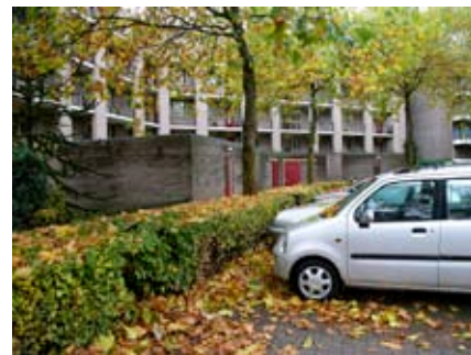
lage haag, daarachter hoge bomen, donker, gesloten gevelvlak bergingen en weefsel van lichte metselwerkstroken en vloeren.
