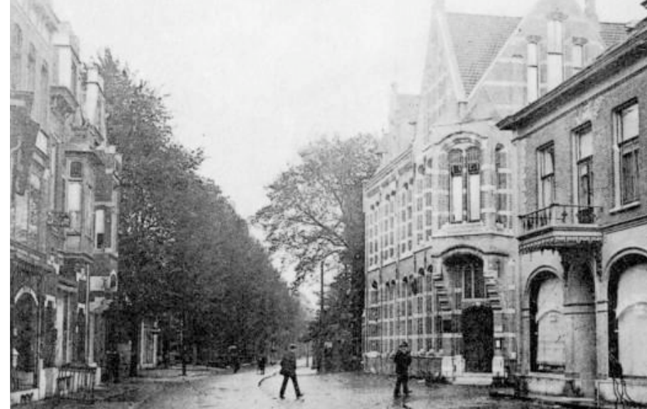
abrupte overgang historische kern en uitvalsweg: Deventerstraat (bron: CODA)
