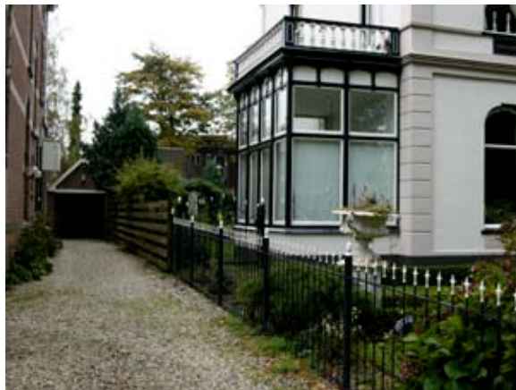
Een beeldvullend doorzicht tussen twee villas, waarin het lommerrijke karakter van de zij- en achtertuinten nog overheerst, ook al heeft de tuin rondom het linker pand inmiddels plaats gemaakt voor een berijdbaar oppervlak.
