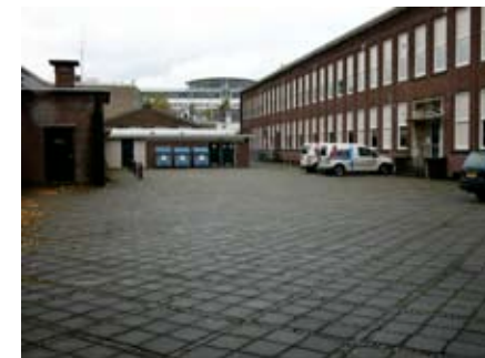
tribune van trafo, containers, loods, lange wand rechts, stadhuis op de achtergrond.
